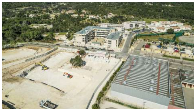
Le Garance, un vaste chantier au cœur du nouveau quartier
