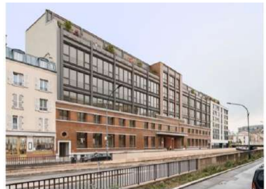
La Distillerie © ailleurs.studio_B&B-architectes
